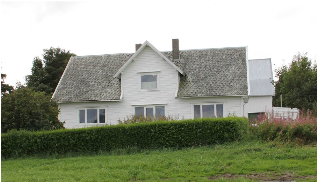
Figur 4.2. Våningshuset på det opprinnelige gårdstunet til bruk nr 492. SEFRAC ID 11270301008. Mot nord. Foto: Ø. Engedal.
